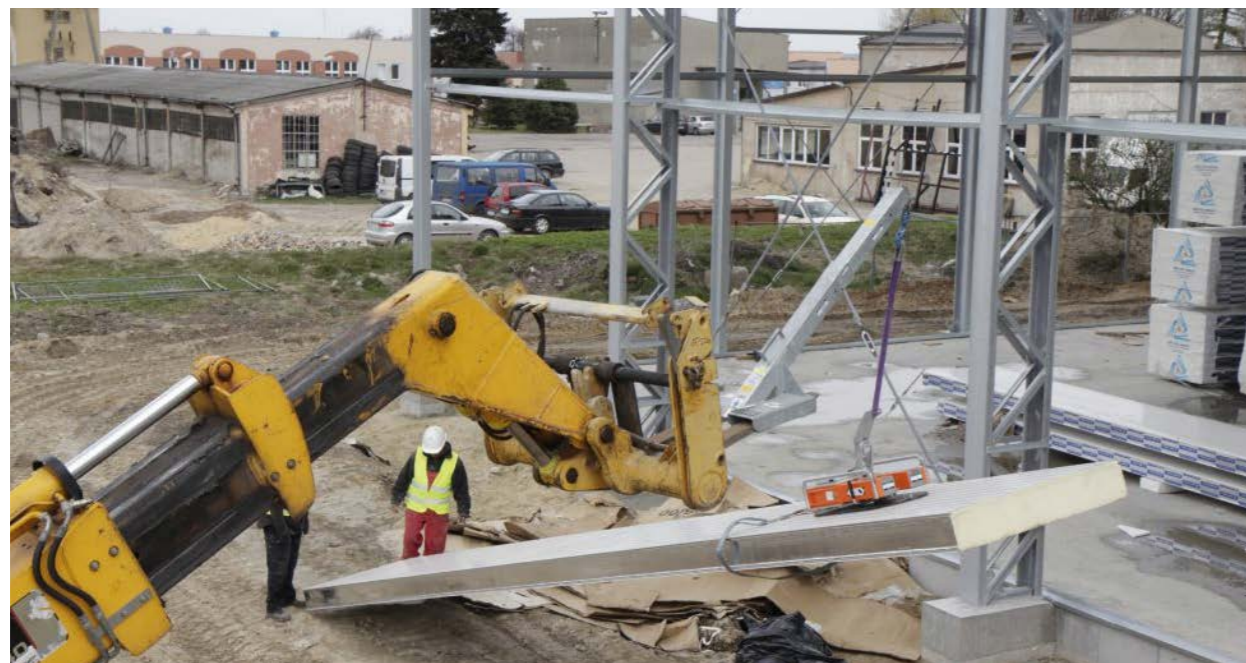
Zdjęcie nr 10. Podnoszenie płyty przysawką próżniową (montaż pionowy).
