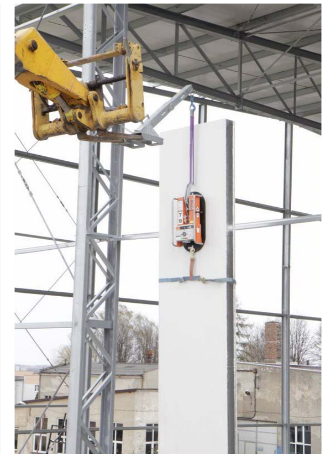
Zdjęcie nr 11. Montaż pionowy ściennych płyt warstwowych.
