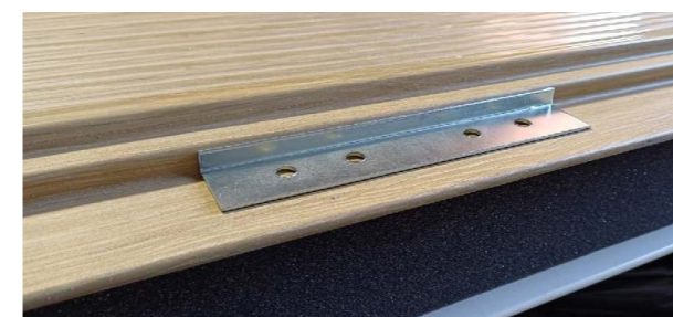
Zdjęcie nr 12. Umieszczenie podkładki PM1 w zamku płyty z ukrytym łącznikiem.
