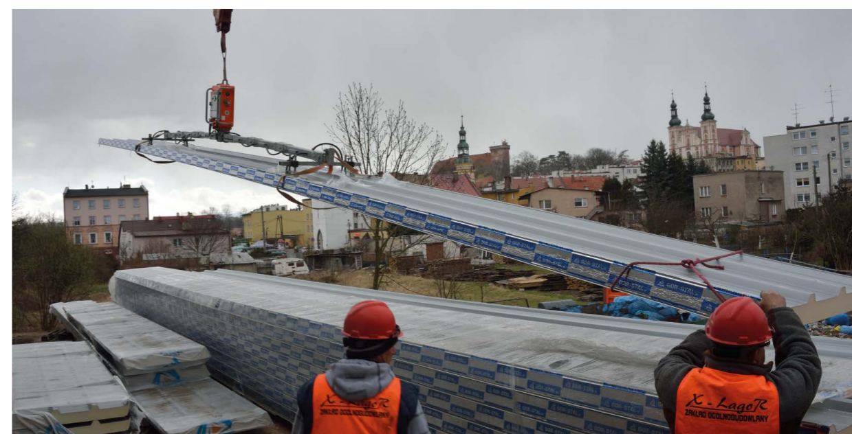
Zdjęcie nr 6. Unoszenie płyty dachowej ze stosu.
