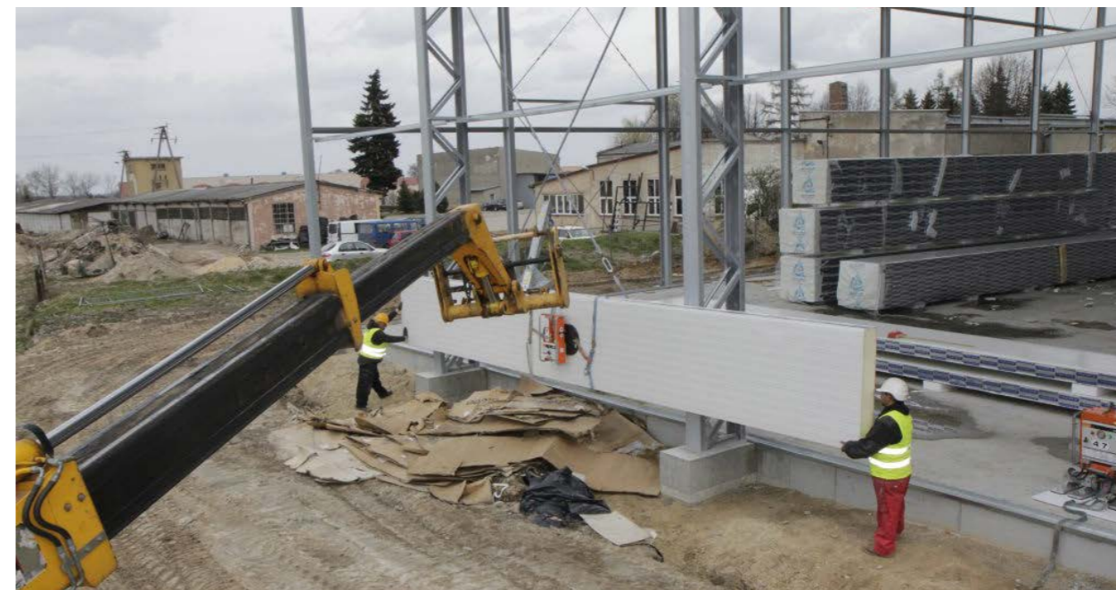
Zdjęcie nr 9. Montaż poziomy ściennych płyt warstwowych.
