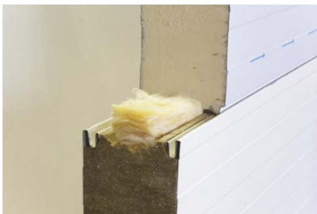
Zdjęcie. nr 2. Widok połączenia (poglądowy)
